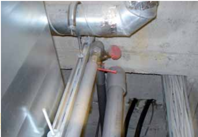
Skryté uzavreté slučky v systéme cirkulácie teplej vody, ktoré poskytujú priestor pre množenie legionelly – Zdroj: OMF1
