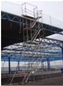
Obr. 13: Voľne stojace schodišťa k lešeniu
