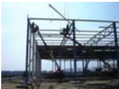
Obr. 5: pohybujúce sa vyvýšené pracovné lešenia a plošiny
