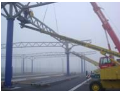
Obr. 9: Predbežná montáž stavebných dielov dole na zemi
