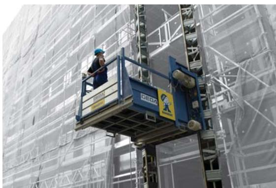
■ Pre vertikálnu dopravu ľudu, stavebných materiálov alebo pomocného zariadenia môže slúžiť aj elektrický žeriav namontovaný na vonkajšiu stenu stavanej alebo rekonštruovanej budovy. Nevyžaduje značné finančné náklady a úplne vylučuje nevyhnutnosť vynášať materiály do vyšších poschodí.
