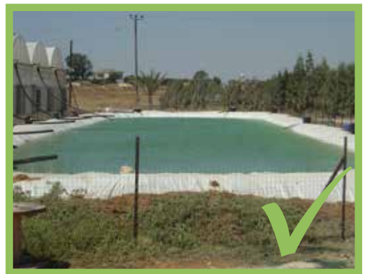
Oplotte zásobníky vody, výkopy alebo kanály alebo prístup k nim inak zamedzte.
