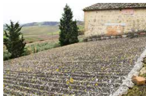
Po dokončení prác prikryte miesto miešania.
