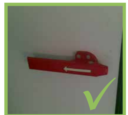
Jednoduchý východ – umiestnite v chladiarenských komorách otváracie rukoväte.
